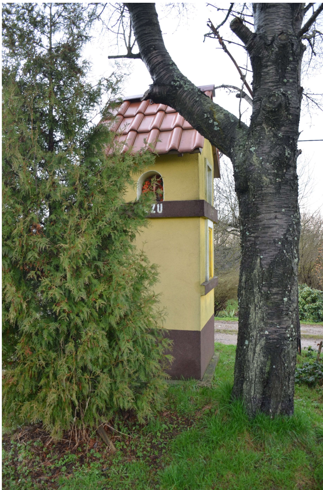
Fot. nr 2. Kapliczka słupowa w Bachorowicach. Widoczne na fotografii: okładzina dociepleniowa przestaniająca zasadniczą bryłę architektoniczną kapliczki. Fot. Mariusz Wrona
