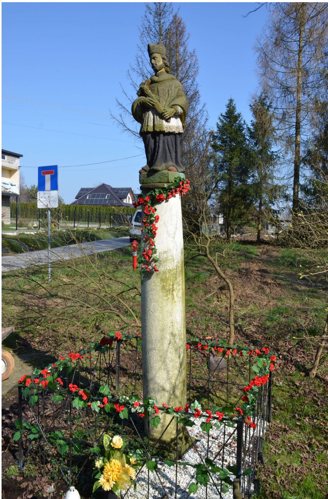
Fot. nr 1. Kamienna kapliczka Świętego Jana Nepomucena. Widoczne na fotografii: liczne nawarstwienia na powierzchni kamienia, przemalowania, ubytki i zbrudzenia kamienia.
