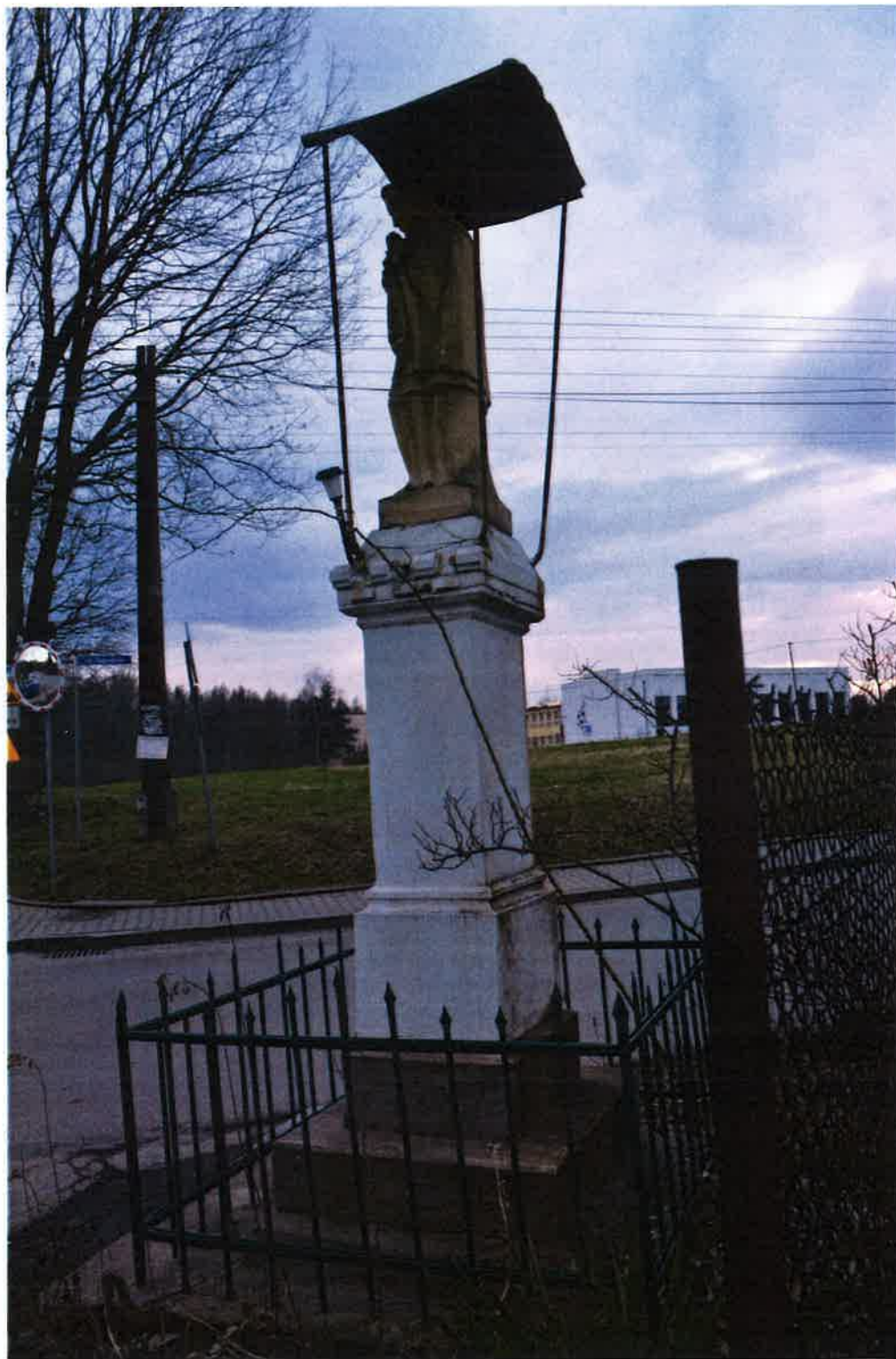
Fot. nr 2. Kamienna kapliczka Św. Jana Nepomucena w miejscowości Tłuczań. Widoczne na fotografii: liczne nawarstwienia na powierzchni kamienia, obrzutka tynkarska, przemalowania. Fot. Mariusz Wrona
