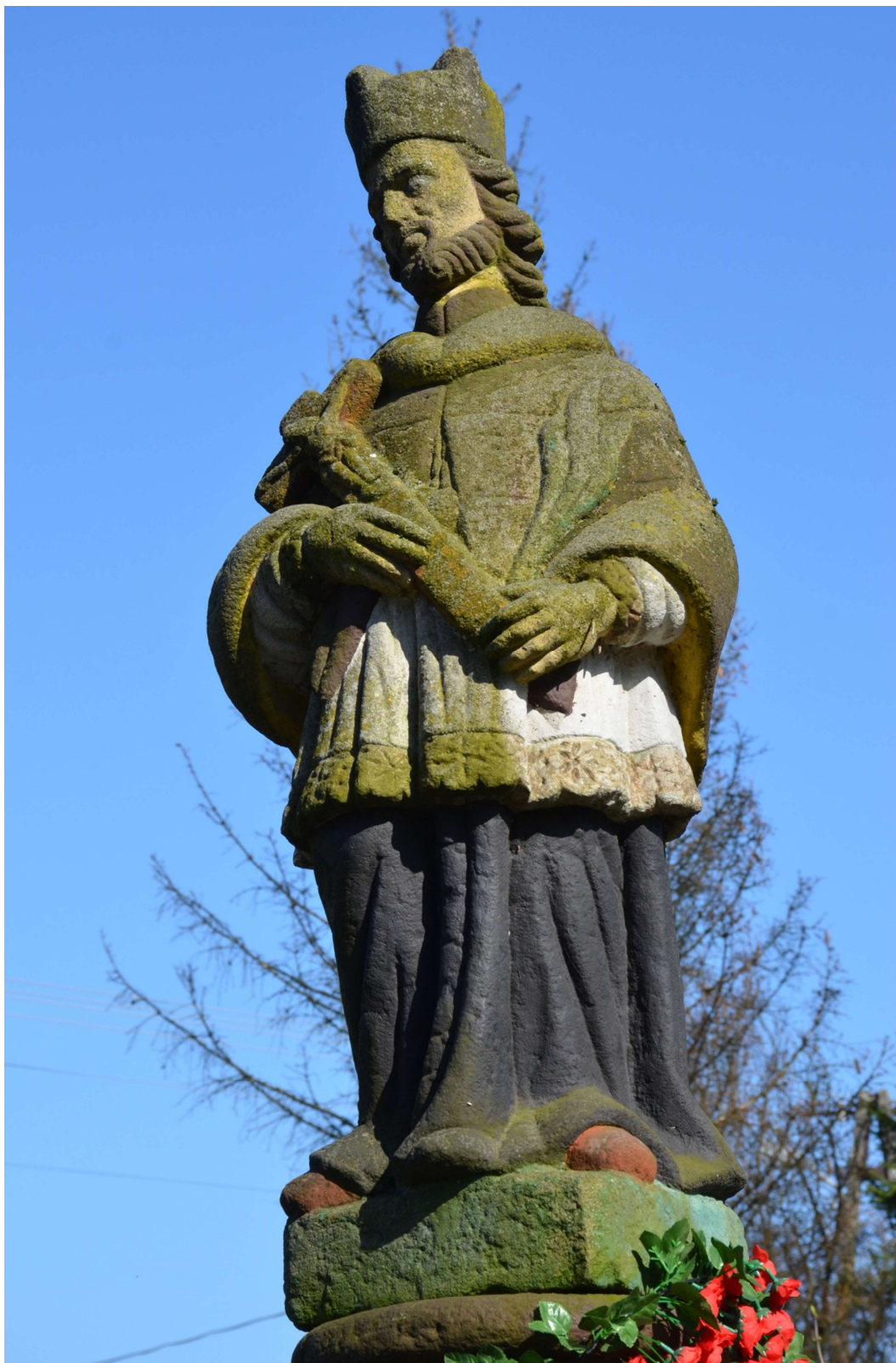
Fot. nr 3. Kamienna kapliczka Świętego Jana Nepomucena. Widoczne na fotografii: liczne nawarstwienia na powierzchni kamienia, przemalowania, ubytki i zbrudzenia kamienia.
