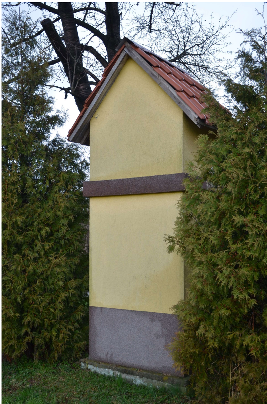
Fot. nr 4. Kapliczka słupowa w Bachorowicach. Widoczne na fotografii: okładzina dociepleniowa przestaniająca zasadniczą bryłę architektoniczną kapliczki.
