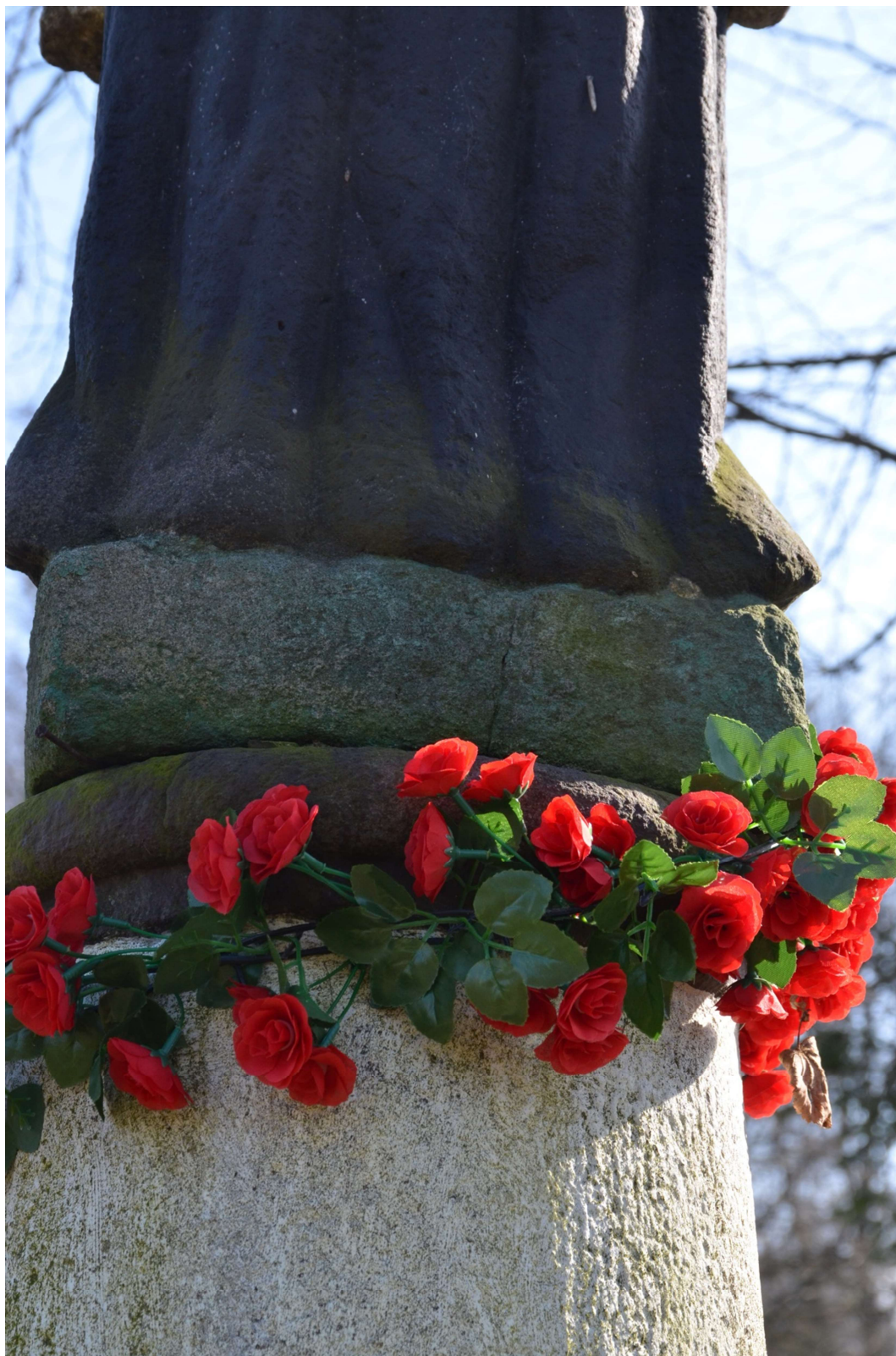
Fot. nr 4. Kamienna kapliczka Świętego Jana Nepomucena. Widoczne na fotografii: pęknięcie podstawy figury wynikające prawdopodobnie z korozji stalowej kotwy montażowej.
