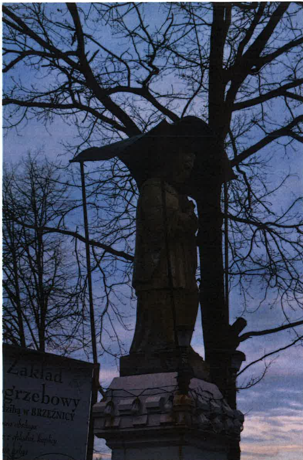
Fot. nr 4. Kamienna kapliczka Św. Jana Nepomucena w miejscowości Tłuczaków. Widoczne na fotografii: liczne nawarstwienia na powierzchni kamienia, przemalowania, mchy, mechaniczne uszkodzenie zadaszenia.
