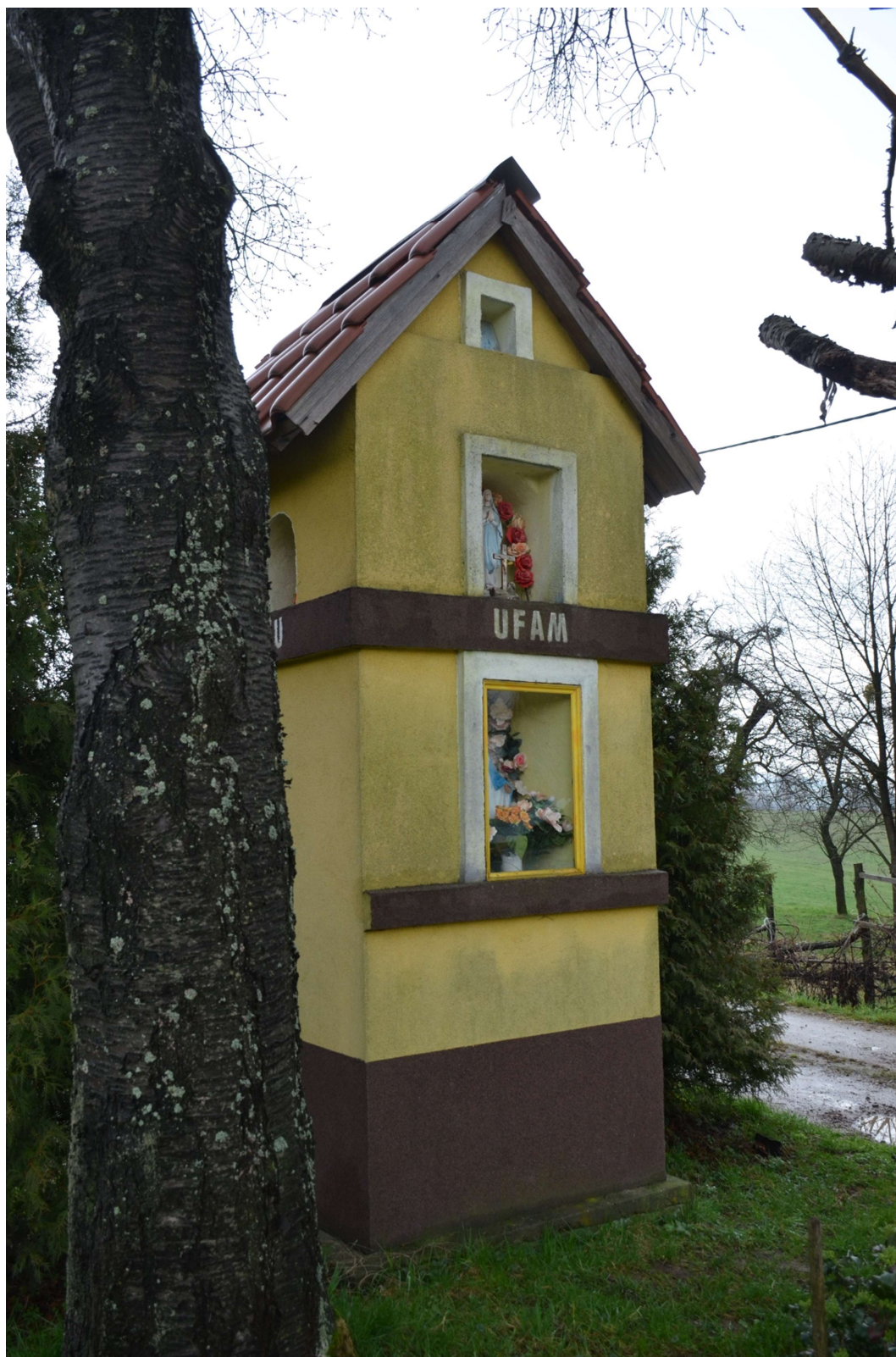
Fot. nr 1. Kapliczka słupowa w Bachorowicach. Widoczne na fotografii: okładzina dociepleniowa przestaniająca zasadniczą bryłę architektoniczną kapliczki.
