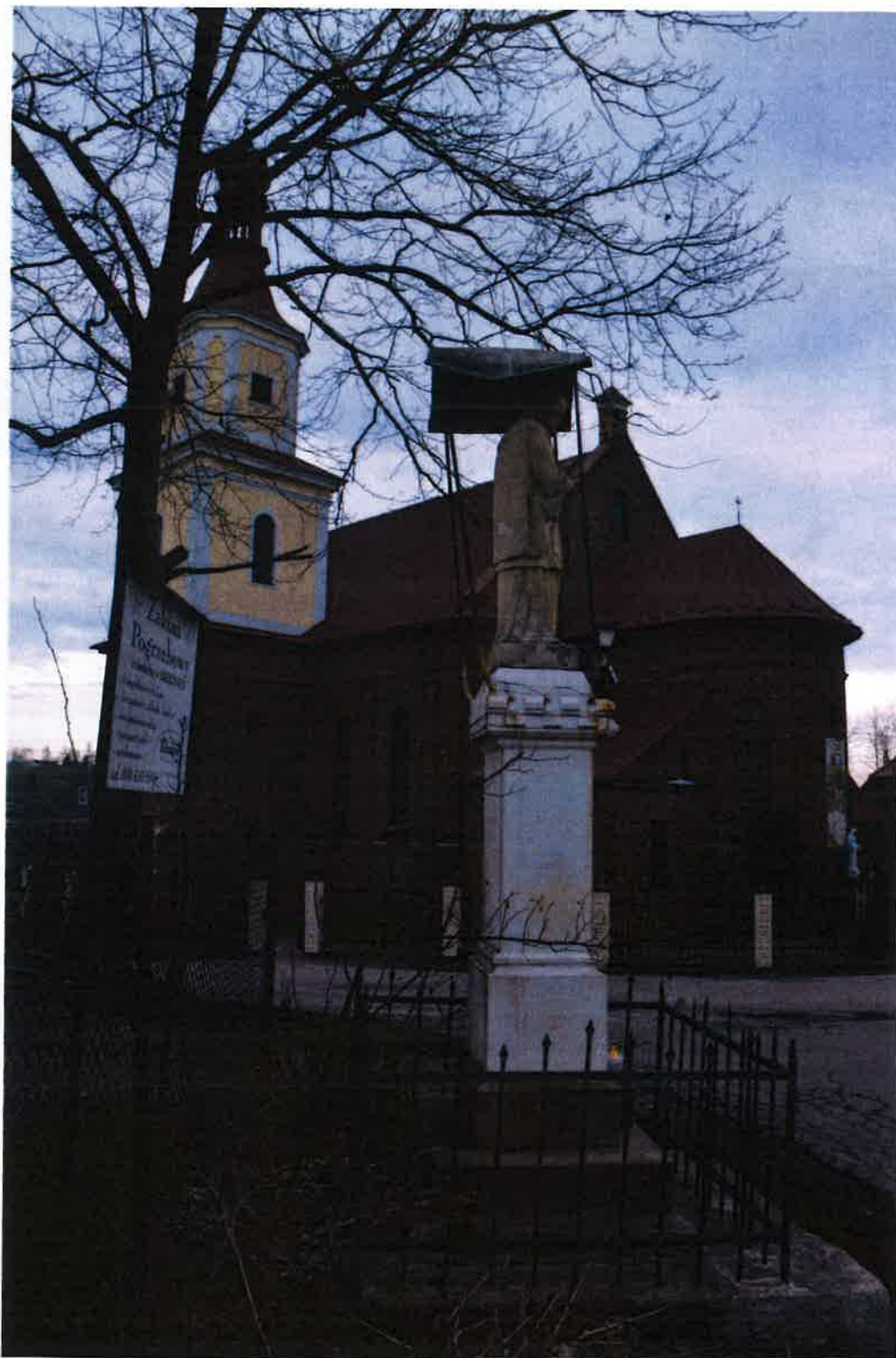
Fot. nr 3. Kamienna kapliczka Św. Jana Nepomucena w miejscowości Tłuczań. Widoczne na fotografii: liczne nawarstwienia na powierzchni kamienia, obrzutka tynkarska, przeomalowania, mchy, glony i mikroorganizmy pokrywające cokół kapliczki.
