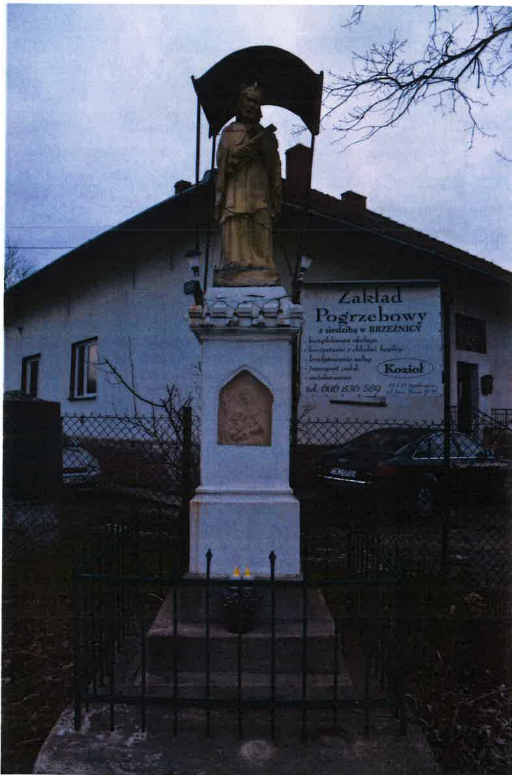
Fot. nr 1. Kamienna kapliczka Św. Jana Nepomucena w miejscowości Tłuczań. Widoczne na fotografii: liczne nawarstwienia na powierzchni kamienia, obrzutka tynkarska, przemalowania.
