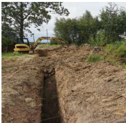
Budowa kanalizacji w Brzeźnicy
